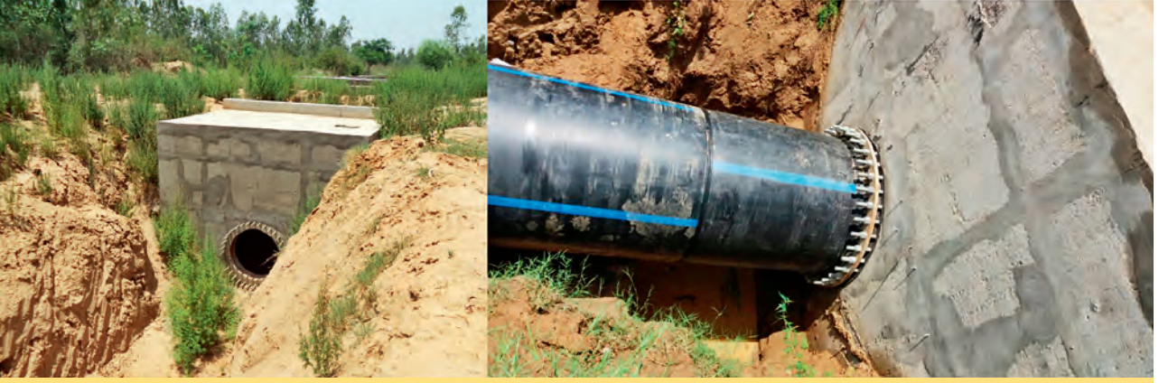
कालव्याचे रुपांतर केले जमिनीखालील पाईपात
